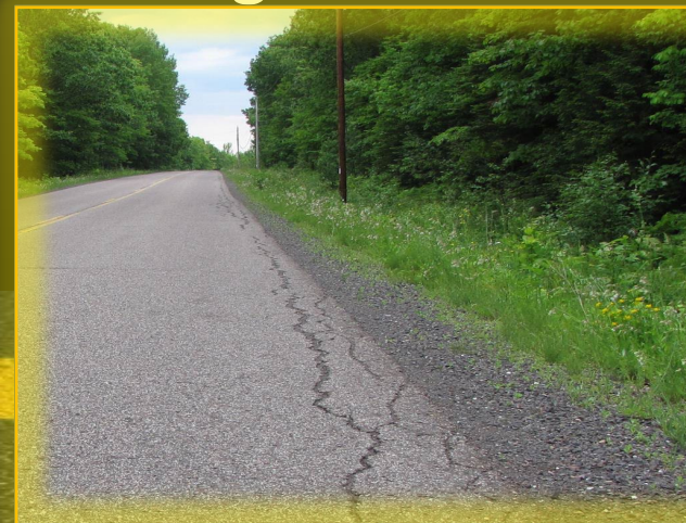
Edge Crack
