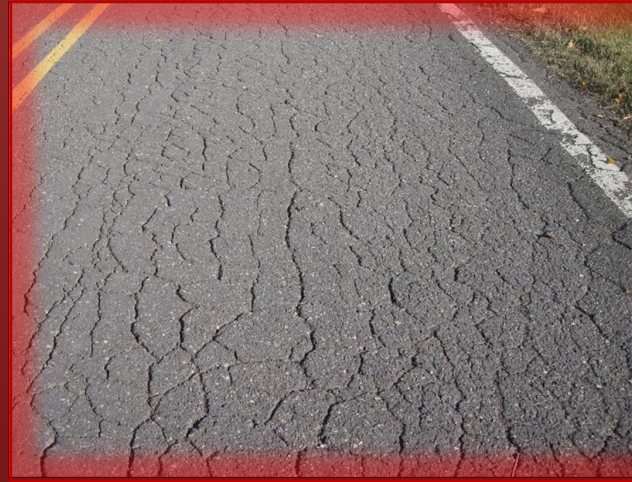
Fatigue Crack
